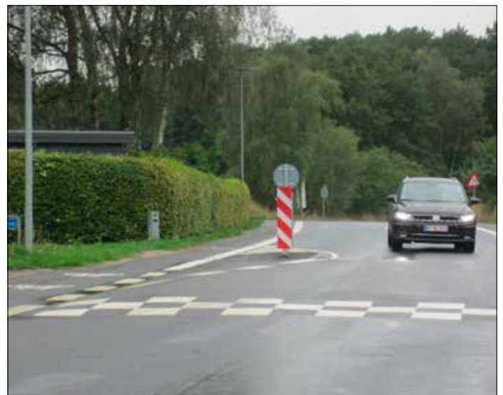
Nu har også Skæggær fået fartdæmpning efter pres fra Lokalrådet.
